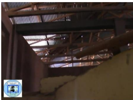
immagini della nuova ala in costruzione
